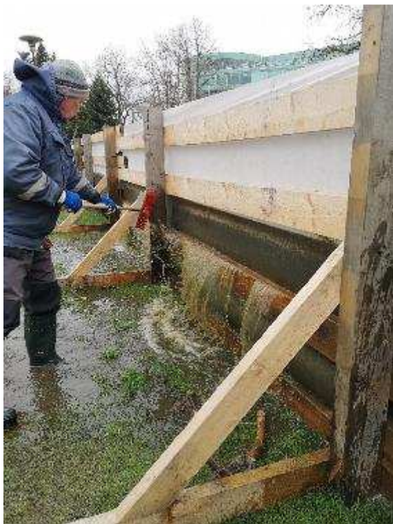
Pilt 4.3. Liigvee nõrgumine läbi basseini piirdebarjääri (Tallinn Snelli park, mai 2021)
